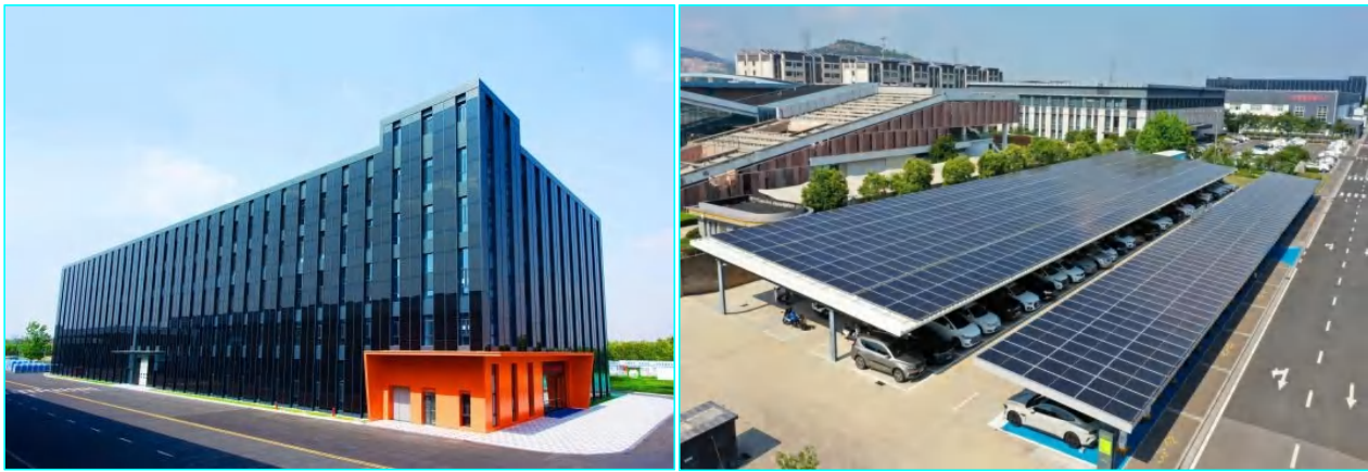
图表9：零碳大楼BIPV光伏幕墙及光储充一体化车棚
