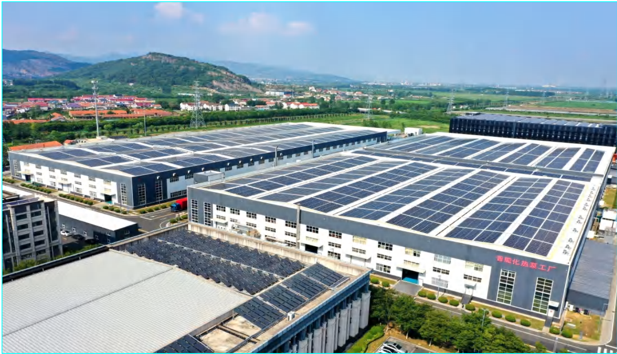
图表8：日出东方连云港基地空气能工厂#1、#2厂房屋顶光伏
